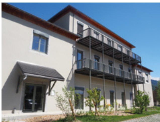
APRES LES TRAVAUX
