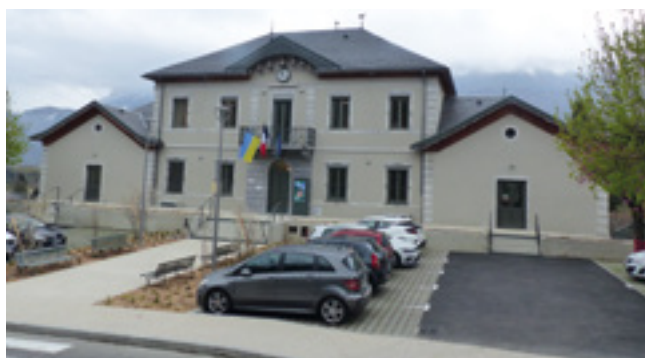
APRES LES TRAVAUX
