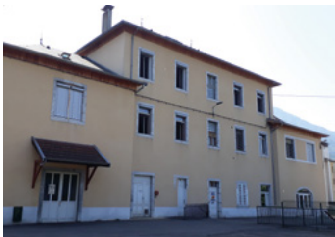
AVANT LES TRAVAUX
