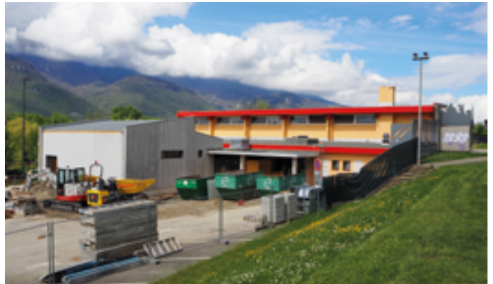
Vue extérieure : le futur Dojo et la nouvelle entrée du Gymnase
