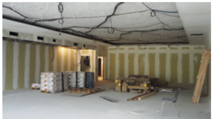
La Salle de Réception en travaux
