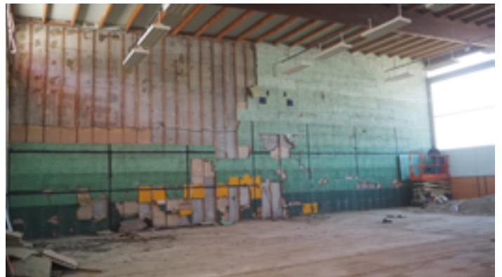
La salle principale du Gymnase, en travaux
