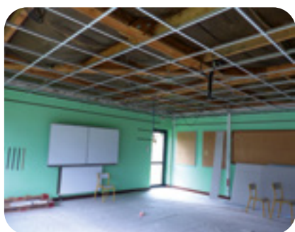
Pendant les travaux
